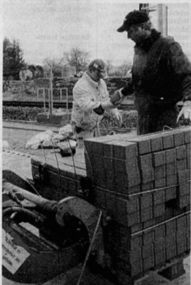
Bis Monatsende sind die Gleisbauarbeiten beendet.
